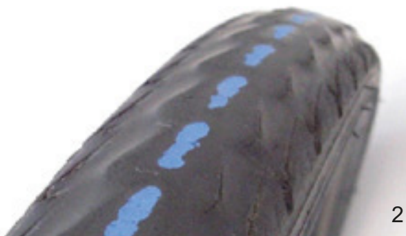
Figura 153: Cubierta sin perfil que aún puede utilizarse (1); cubierta con protección contra pinchazos visible que tiene que cambiarse (2)
