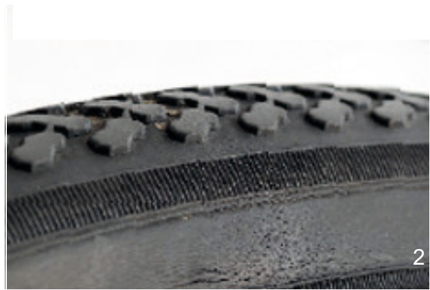
Figura 139: Ejemplos de fisuras por fatiga (1) y fisuras por envejecimiento (2)
